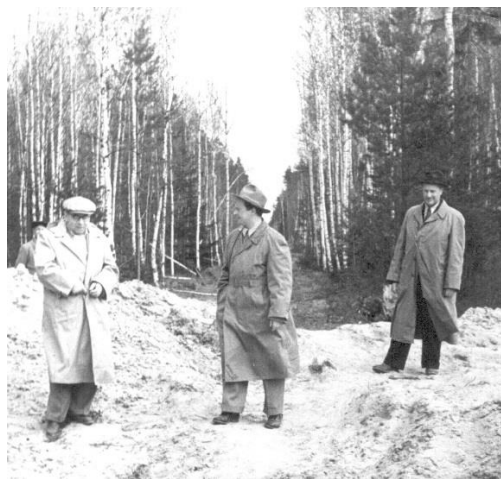
На месте будущего корпуса ОСР на полигоне в пос. Черноголовка
